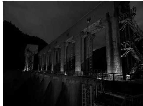
長安ロダム (徳島県那賀町)
